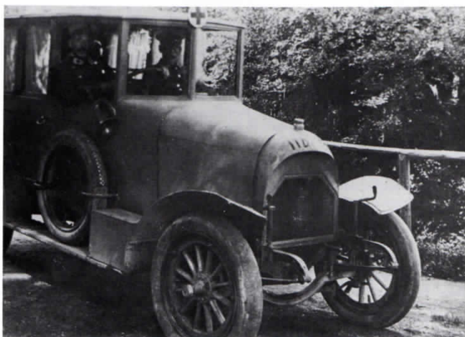
Der zweite »Sanka« der Freiwilligen Sanitätskolonne Dachau. Das gebrauchte Horch-Chassis wurde 1920 vom Roten Kreuz erworben und von Wagnermeister Hans Gessler mit einer bedarfsgerechten Karosserie versehen (Originalaufnahme im Besitz des BRK Dachau).
