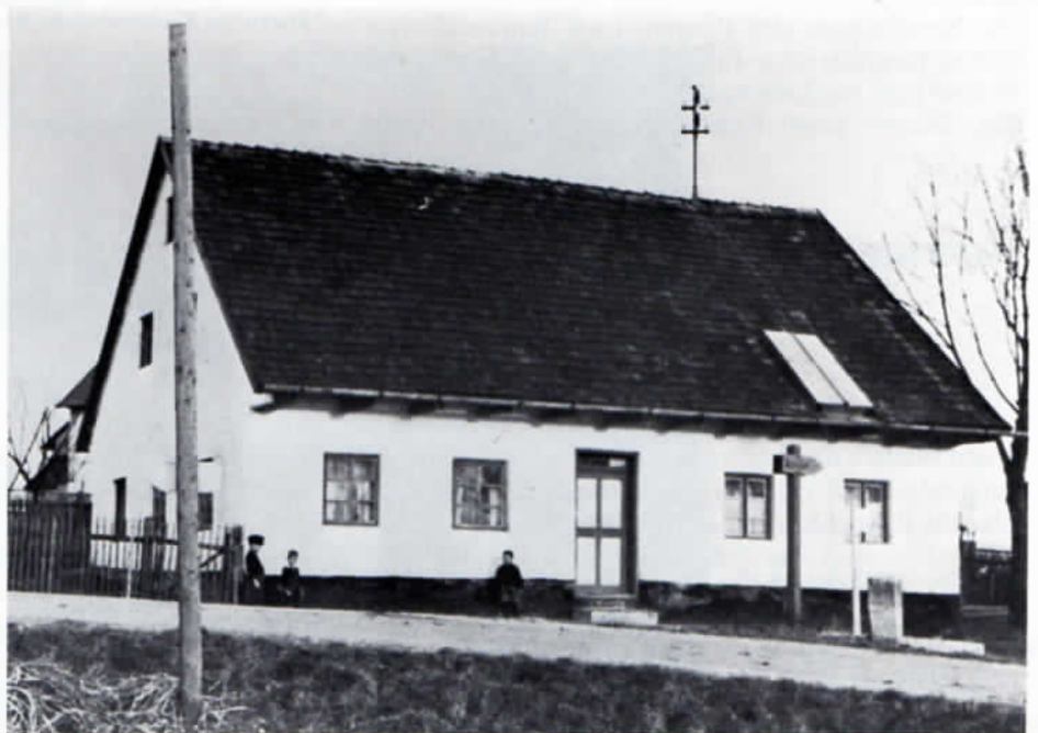
Das Hütthaus von Reichertshausen, wie es 1869 erbaut wurde und bis zum Jahre 1960 bestand.
