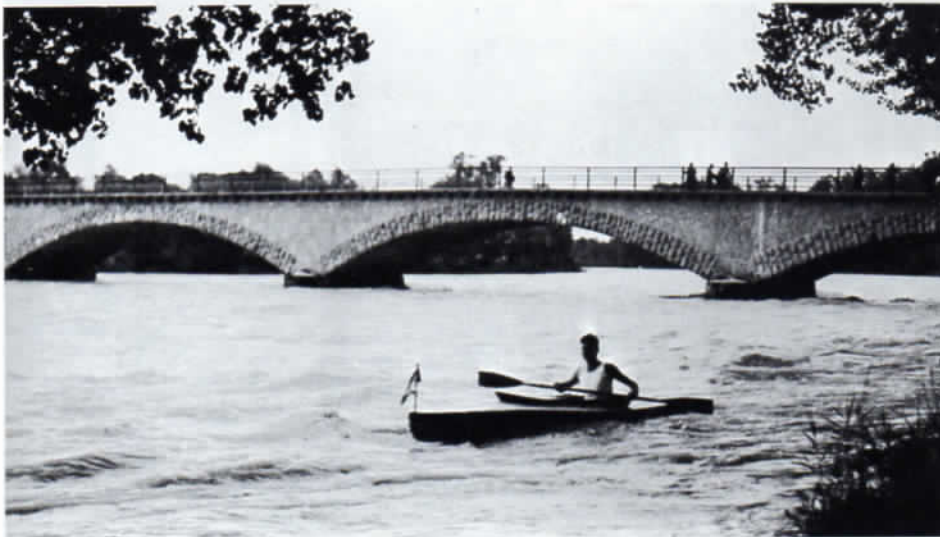
Die 1948 erbaute Freisinger Isarbrücke.
