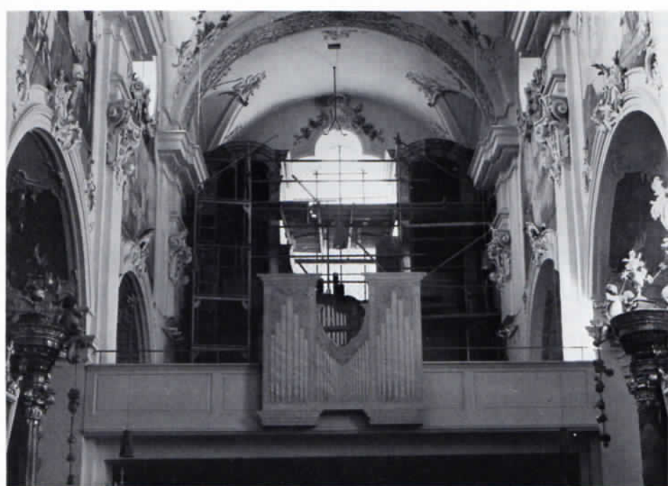
Pfarrkirche Kloster Indersdorf, Orgelgehäuse nach Abnahme aller Verzierungen und Ausbau der Orgel. An der Brüstung des Modells des Rückpositivs (Brüstungsorgel) für das II. Manual. Zustand September 1986.
