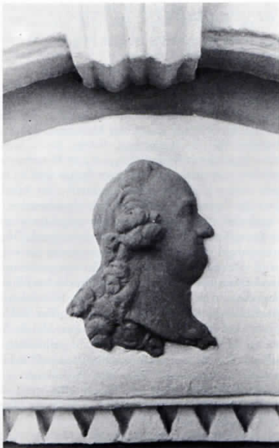
Porträtrelief des Kurfürsten Karl Theodor, als Bauherr des 1790 errichteten kurfürstlichen Kastenamtes, am alten Dachauer Finanzamtsgebäude nach der Freilegung. Die Reliefs waren mit acht Farbschichten übermalt.
