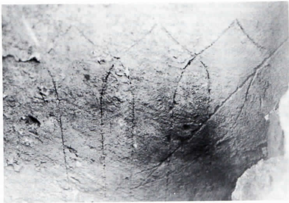
Ritzungen im gotischen Putz für die Ziffer IX und die zugehörige, schräg nach oben verlaufende Stundenlinie.
