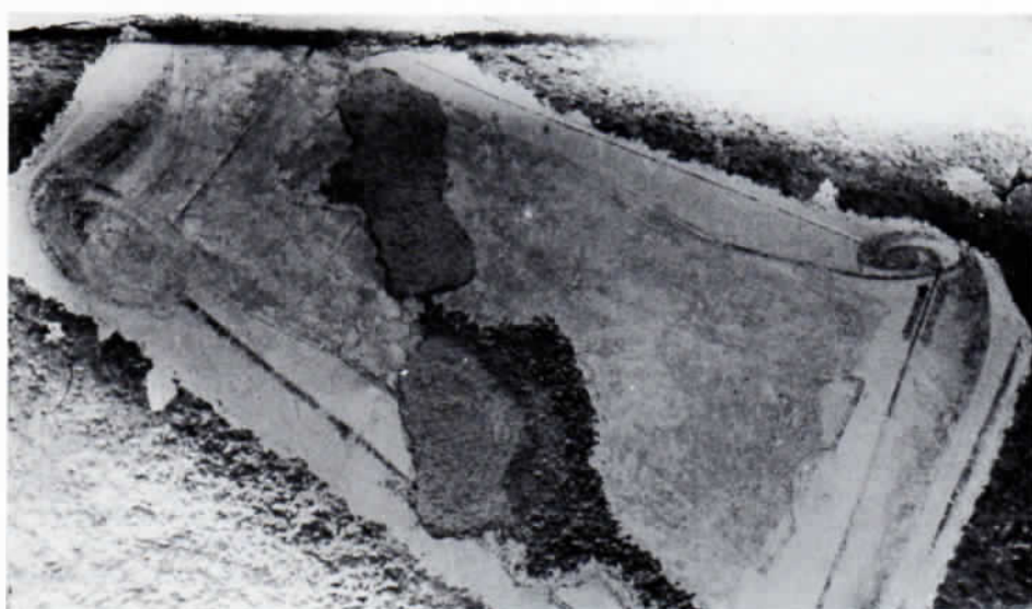
Abb. 3: Das am Schleißheimer Uhrenturm freigelegte Sonnenuhr-Zifferblatt.
