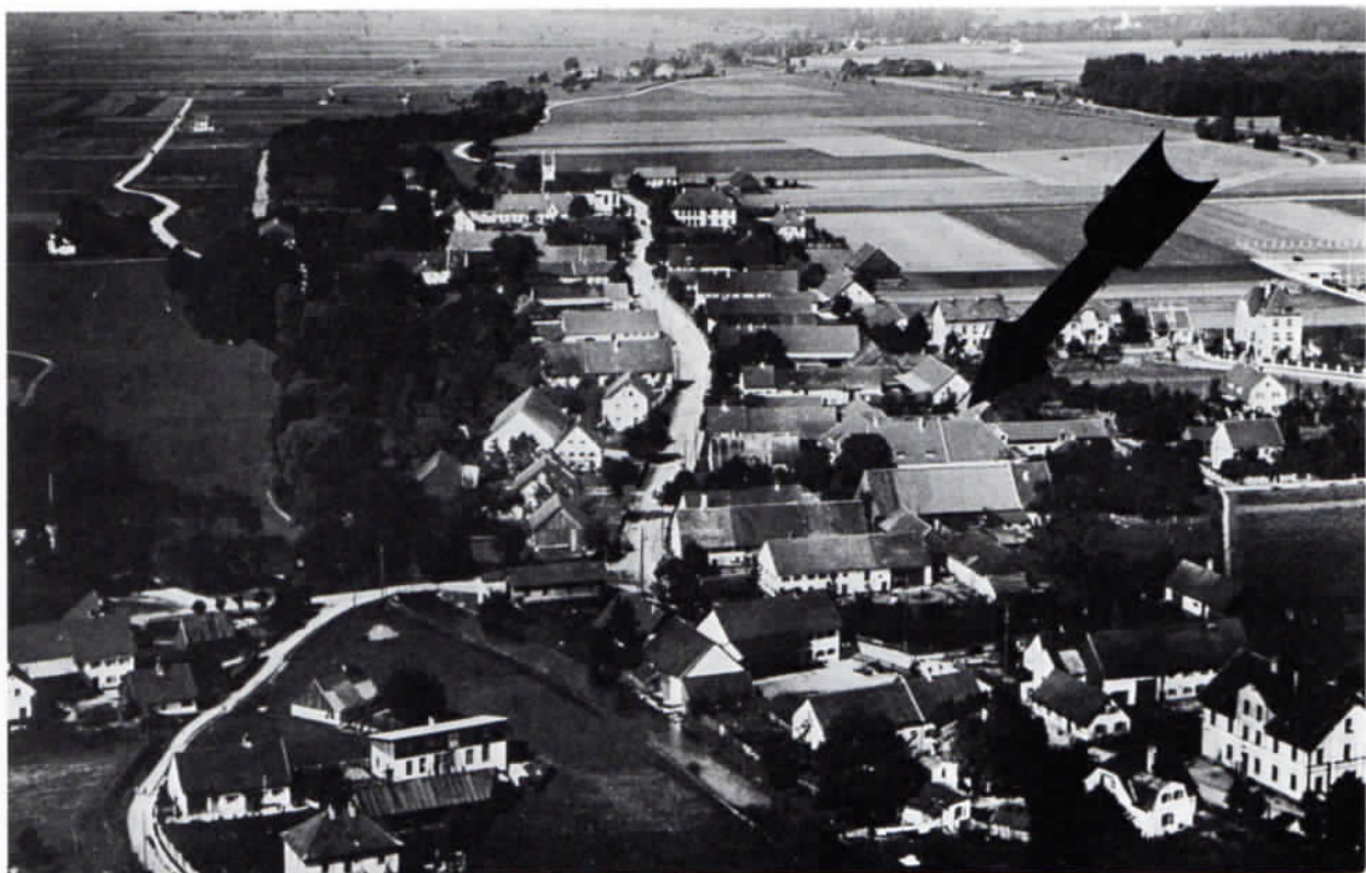
Luftaufnahme des Dorfes Allach im Jahre 1919 von Süd nach Nord. Die Taferne ist durch einen Pfeil markiert. Am nördlichen Dorfausgang die Kirche St. Peter und Paul. Quelle: Stadtarchiv München
