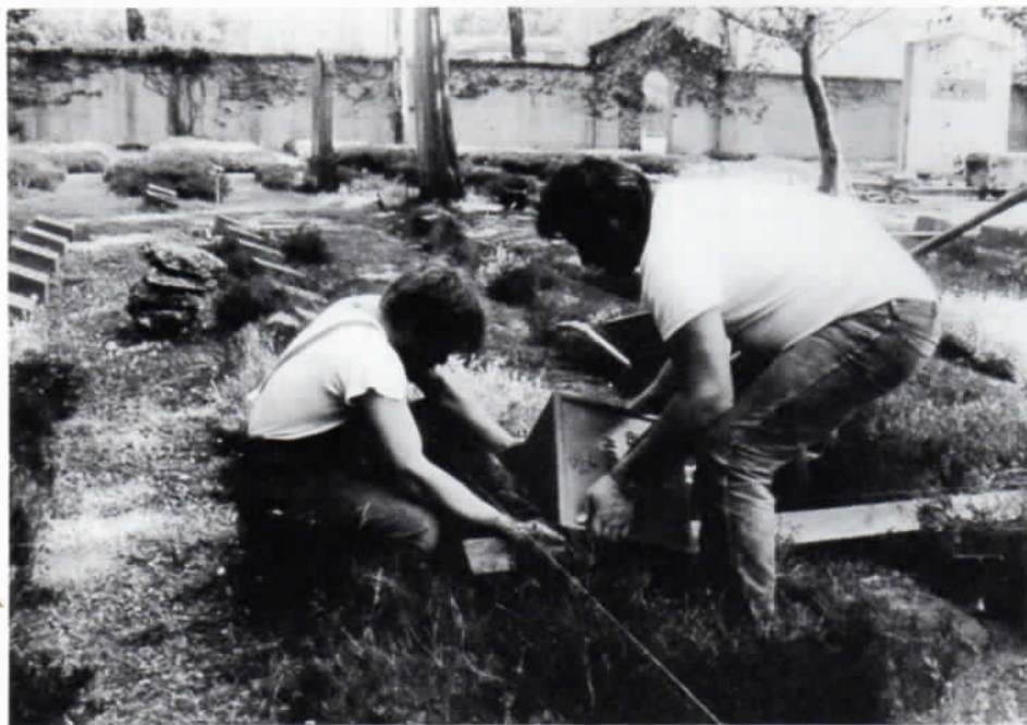
Der russische Soldatenfriedhof in Puchheim. Die keramischen Grabsteine werden frostsicher neu gesetzt.
