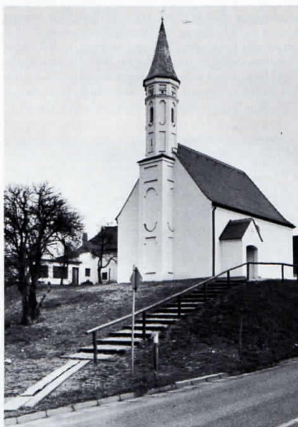
St. Nikolaus in Sulzrain im Dezember 1979 nach der Kirchenrenovierung. Foto: Adolf Kitzberger, Hebertshausen
