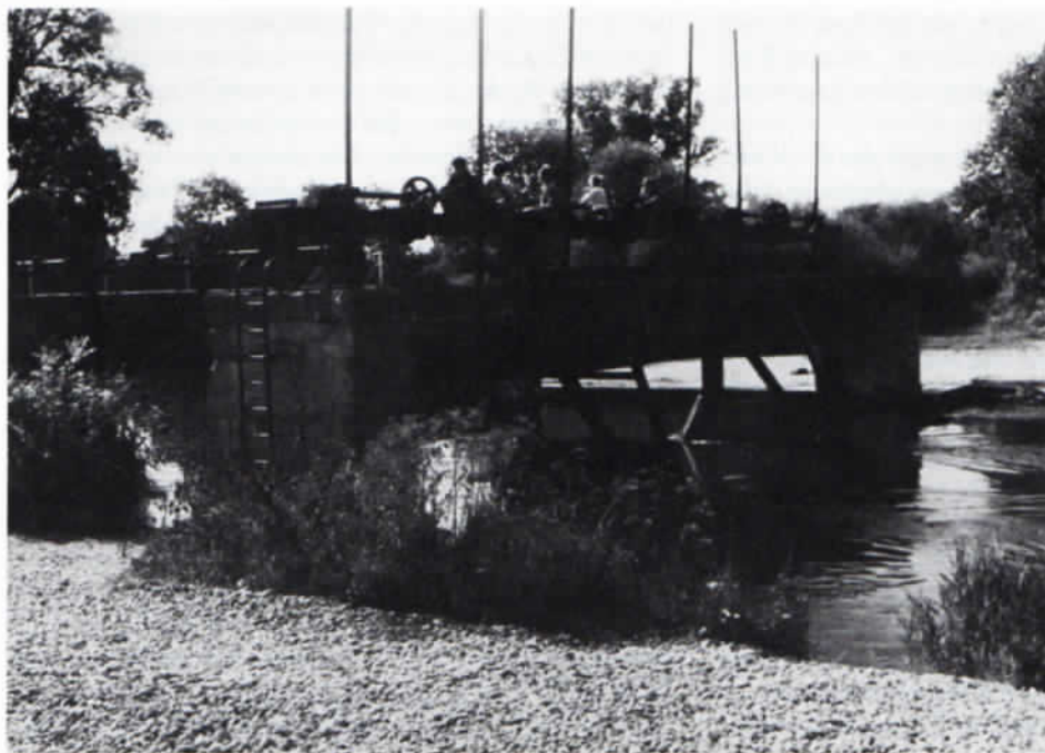
Die obere Schleuse zwischen Olching und Esting, die den zum Werkkanal ausgebauten »Mühlbach« von der Amper trennt und den Wasserdurchfluß regulierbar macht.
