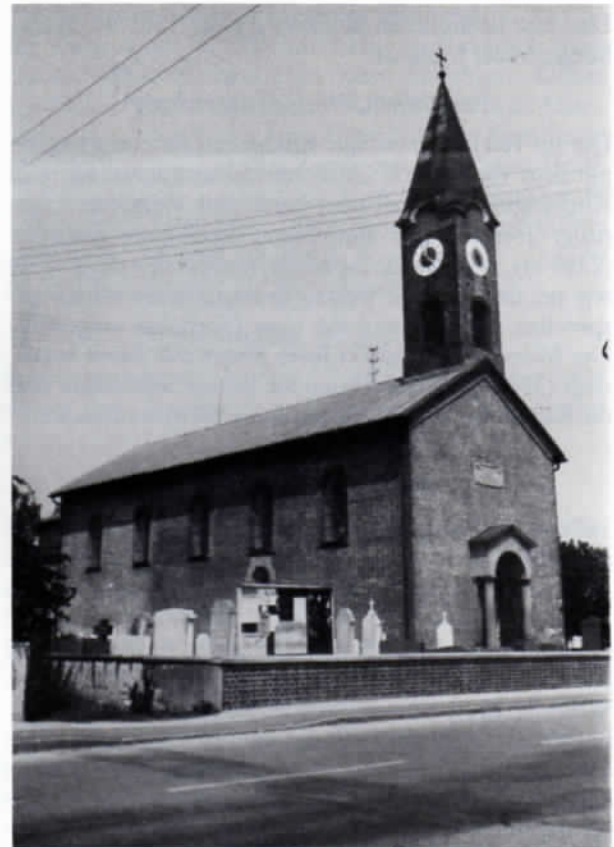
Einer der ersten Kirchenbauten Oberbayerns nach der Säkularisation ist das Hallbergmooser Gotteshaus (Entwurf: Ohlmüller).
