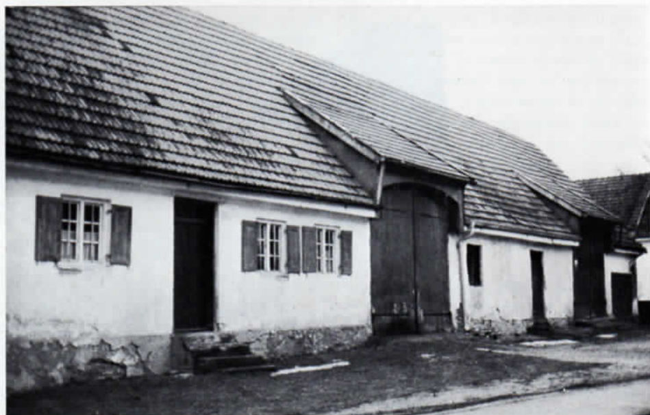
Abb. 3: Der Mittertennbau des Gütlers im Amperland (Ampermoching). Rechts neben dem Stall wurde das Gebäude nachträglich um eine zweite Tenne erweitert. Das hochgezogene Dach über der Tor-einfahrt trägt den Namen »Froschmaul«. Es ist ein charakteristisches Merkmal des Mittertennbaues.
