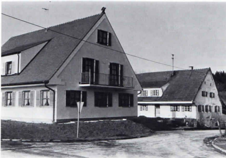
Abb. 9: Vorbildlicher Bauernhausneubau, der die gediegenen Maßstäbe des alten Hauses im Hintergrund zum Vorbild nahm (Westerndorf). Die große, ruhige Dachfläche prägt das Haus. Lediglich der Balkon ist mißlungen. Wird jemals jemand darauf sitzen?
