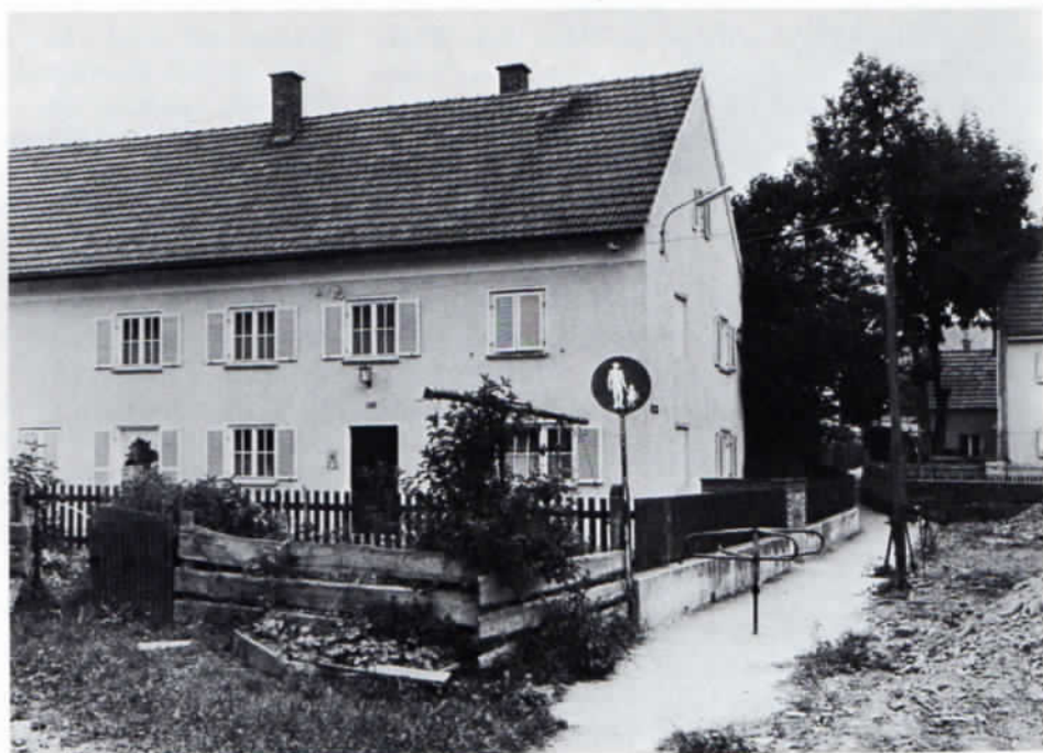
Im unteren Geschöß des ehemaligen Kooperatorhauses wurden 1903 unter Pfarrer Alois Graß und Lehrer Joseph Pfäffel zwei Zimmer zu einem Klassenraum ausgebaut. Bis zum ersten Schulhausbau im Jahre 1825 wurde hier unterrichtet.
