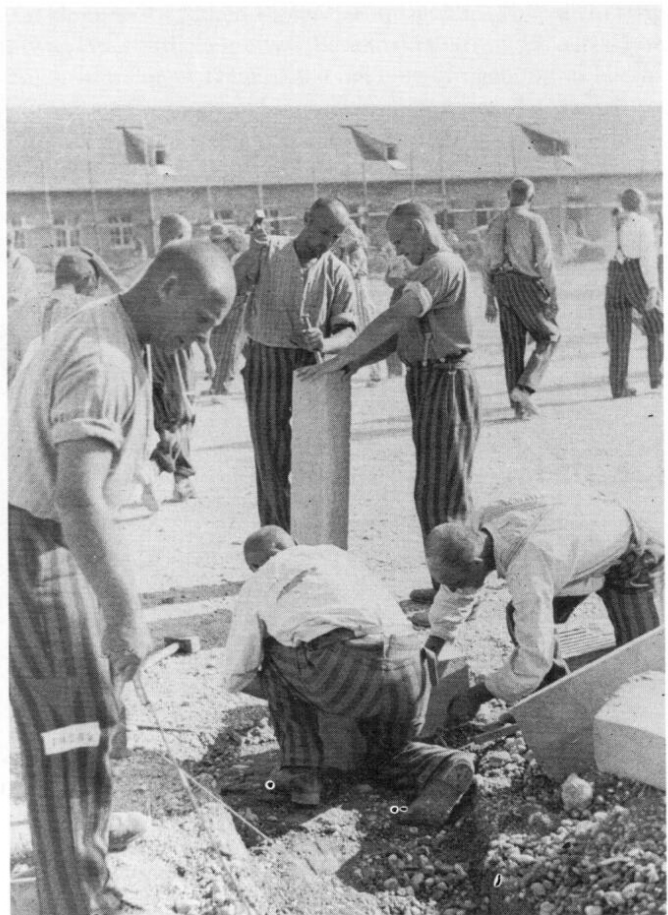
Dachauer Häftlinge bei Fundamentierungsarbeiten im neuen Schutzhaftlager.
