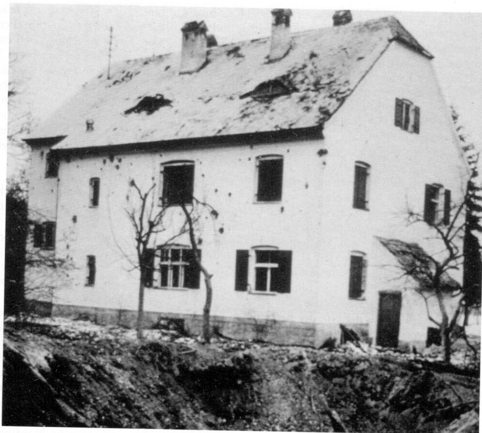
Bombenkrater im Garten des katholischen Pfarramts St. Peter und Paul in der Pfarrstraße. Die Löcher in der Wand rühren von Granatsplittern her.
