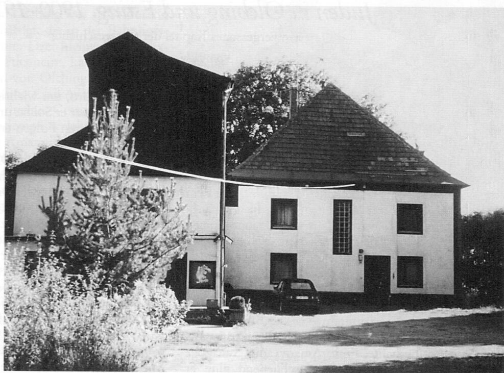
Die ehemalige Mühle in Langwied (linkes Gebäude) im Jahre 1997.
