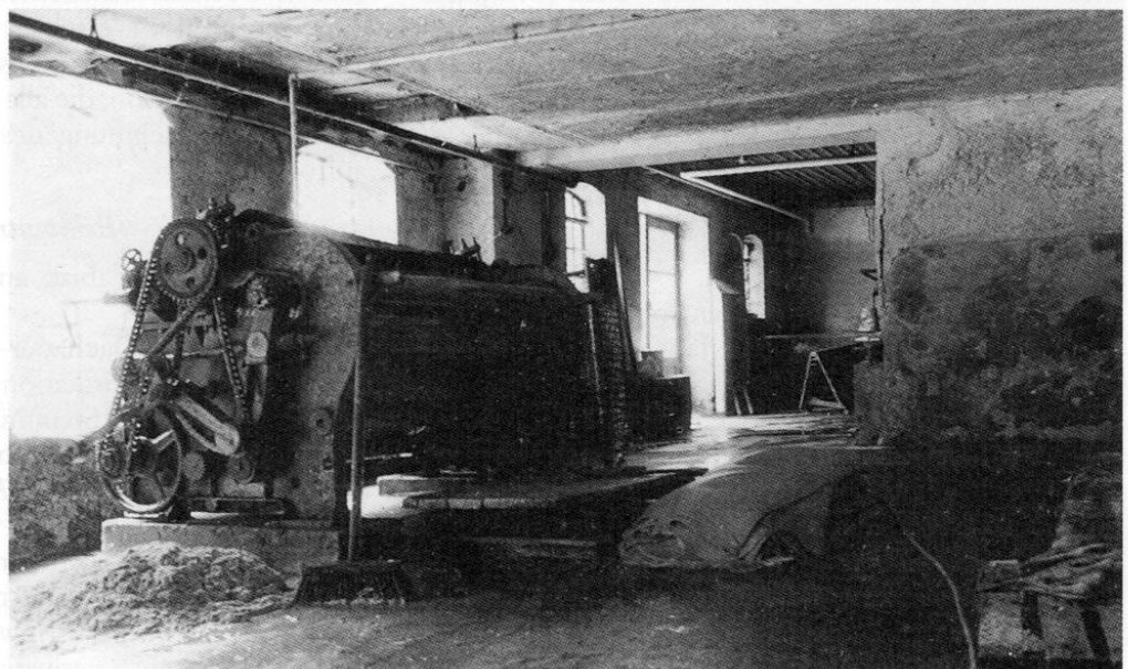
Abb. 9: 1972 wurde in der Rotgerberei Schiela noch eine »Entfleischmaschine« angeschafft, um sich die anstrengende Arbeit des Vorrichtens der Häute zu Blößen auf dem »Scherbam« zu ersparen.
