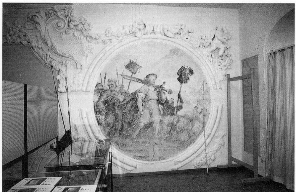
Abb. 2: Nördliches Rundbild der Westseite, verkratzt durch unsachgemäße Freilegung.
