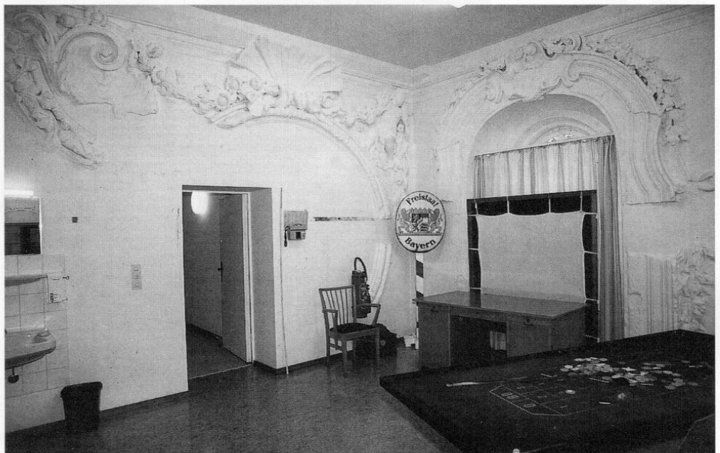
Abb. 3: Südostecke des ehemaligen Fürstensaales mit späteren baulichen Eingriffen und restauratorischer Suchleiste (rechts von Türe und Telefon), welche das Vorhandensein von freskaler Malerei zeigt. Foto: Langosch, Büro Zeh, Jesenwang
