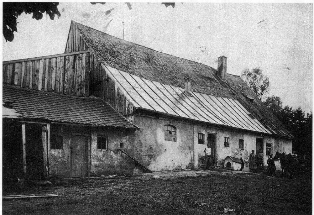
Nordseite der im Jahre 1794 neu erbauten Wasenmeisterbehausung mit angebautem Stall im Dachauer Lederergäßl. Aufnahme aus dem Jahre 1925 kurz vor dem Abriß.
