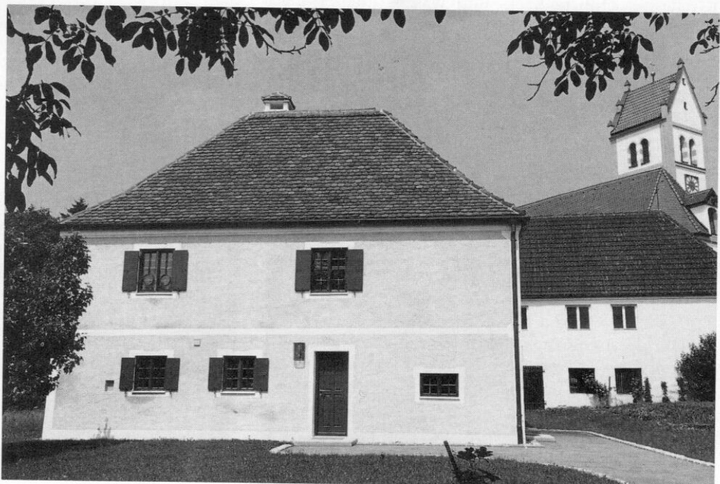
Pfarrheim Dünzelbach nach der Renovierung, Juni 1993. Foto: Jolanda Englbrecht, Westerham
