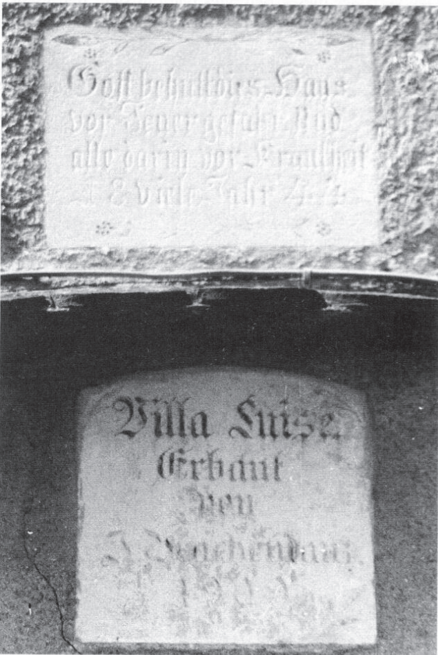
Abb. 1.: Diese fast unleserlichen Tafeln aus unterschiedlichen Jahren befinden sich in Gelbenholzen, Ortsteil von Fürstfeldbruck.
