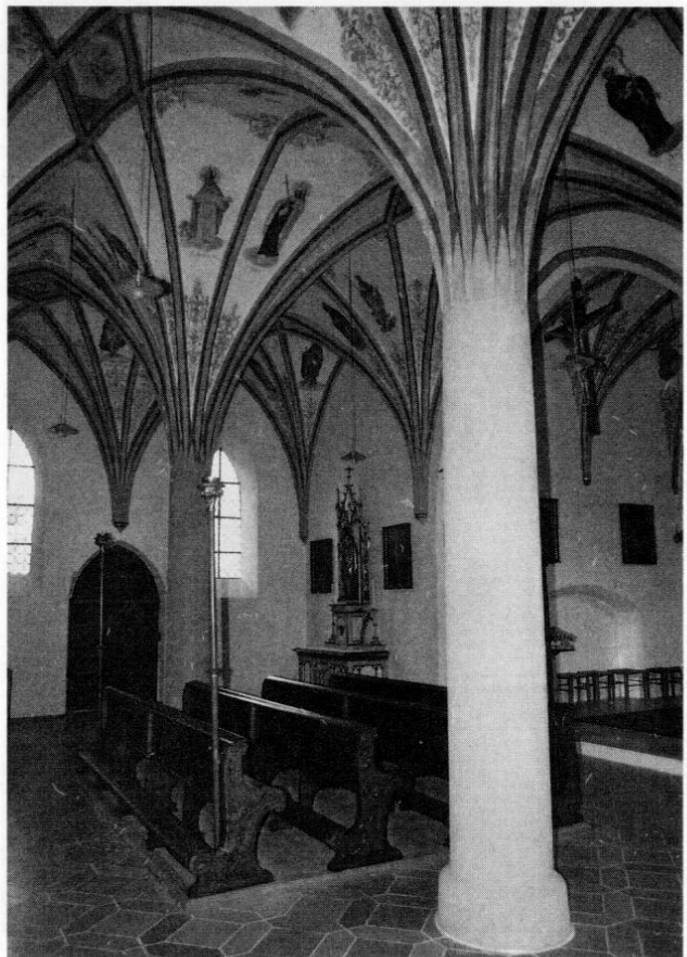
Abb. 4: Blick ins nördliche Seitenschiff nach der Innenrestaurierung. Foto: Alexander Zeh, Jesenwang
