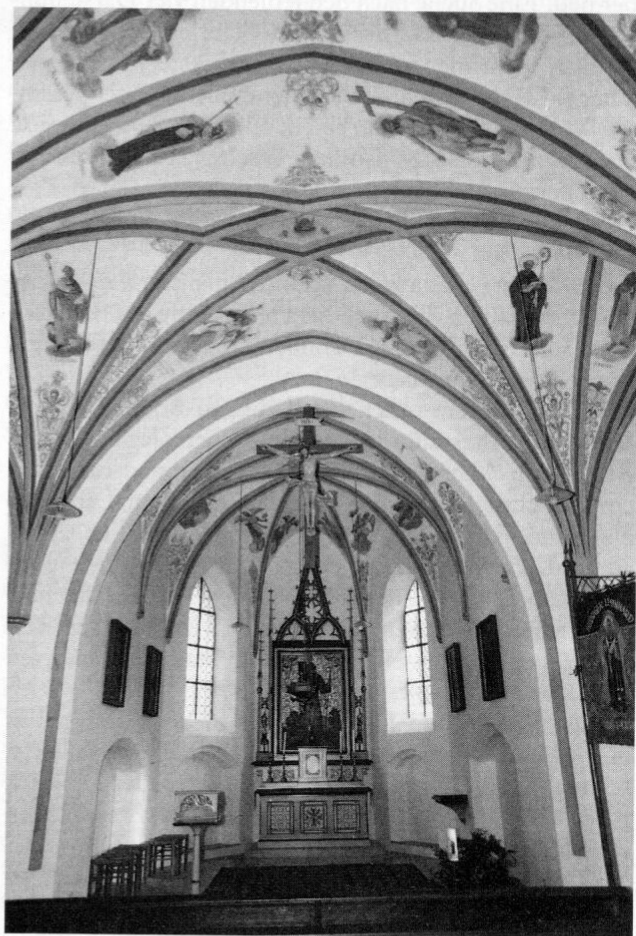
Abb. 6: Altarraum nach der Innenrestaurierung.
