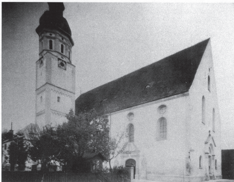
Nordwestansicht der Pfarrkirche St. Magdalena, Fürstenfeldbruck, aus der Zeit vor der Neugestaltung 1912/13.
