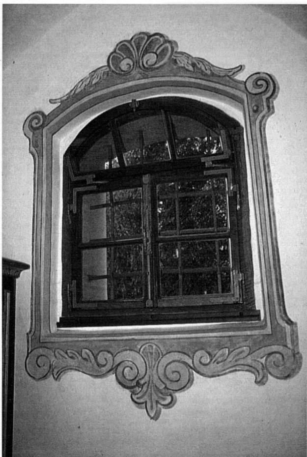
St. Stephan in Stephansberg, freigelegte und restaurierte Renaissancefassung am Sakristeifenster
