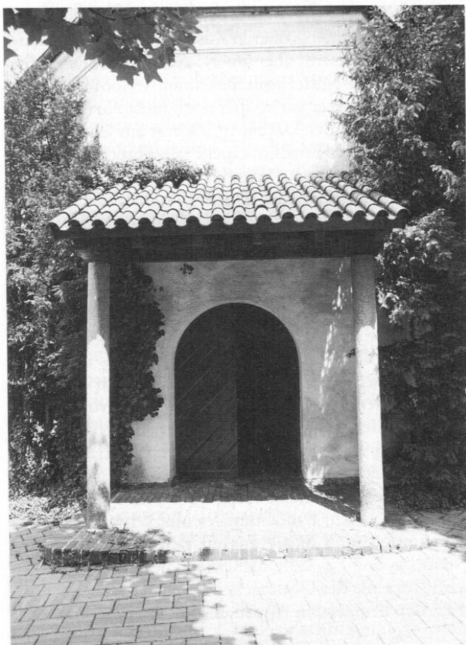
Eingang der Dachauer Gottesackerkapelle, Sommer 1991. Foto: Stadt Dachau
