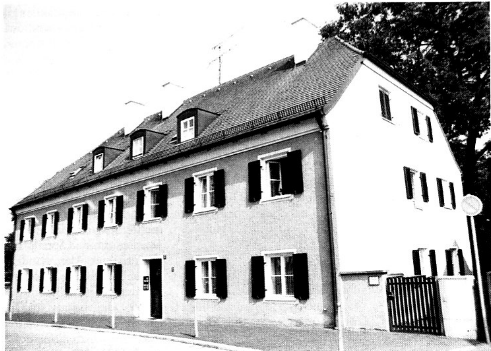
Das Dachauer Bürgerspital, Gottesackerstraße 5. 1819/20 als Armenhaus erbaut. Foto: Ludwig Ernst, Dachau
