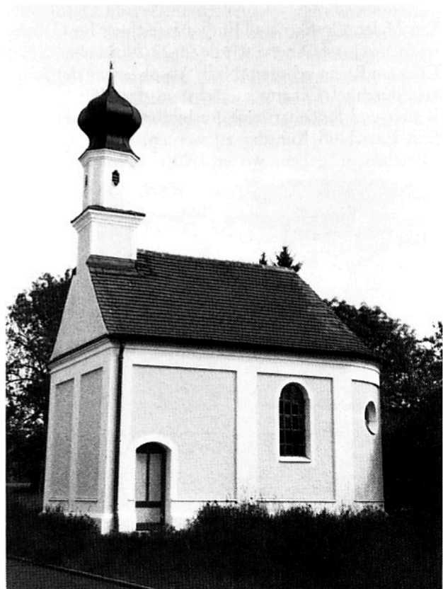
Die Kapelle St. Richard in Miesberg nach der Renovierung 1991. Foto: Alexander Zeh, Jesenwang
