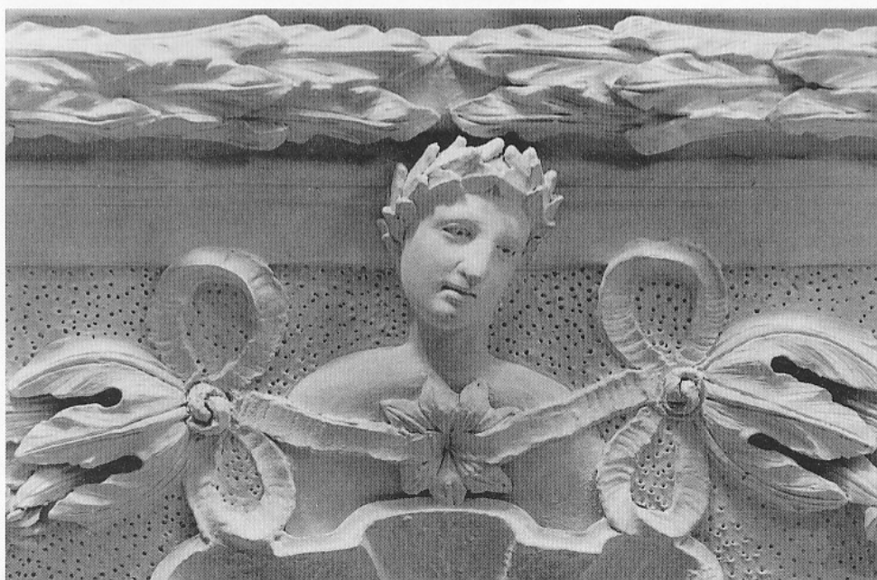
Abb. 4: Schloß Unterweikertshofen, Stuckdecke um 1700, Detail (Archiv E. Burmeister, München).
