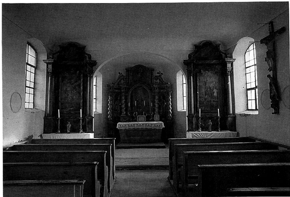
Albertshofen, St. Laurentius: Zustand im Inneren vor der Renovierung 1989.
