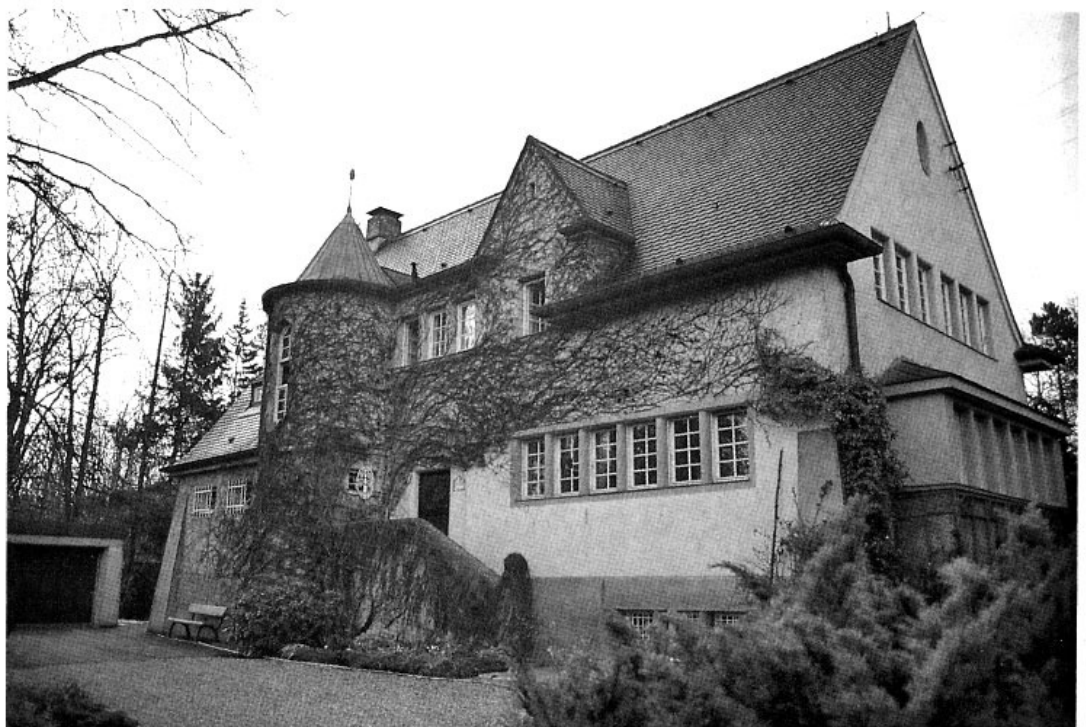
Emmeringer Straße 43, 1909 nach englischen Vorbildern errichtet.
