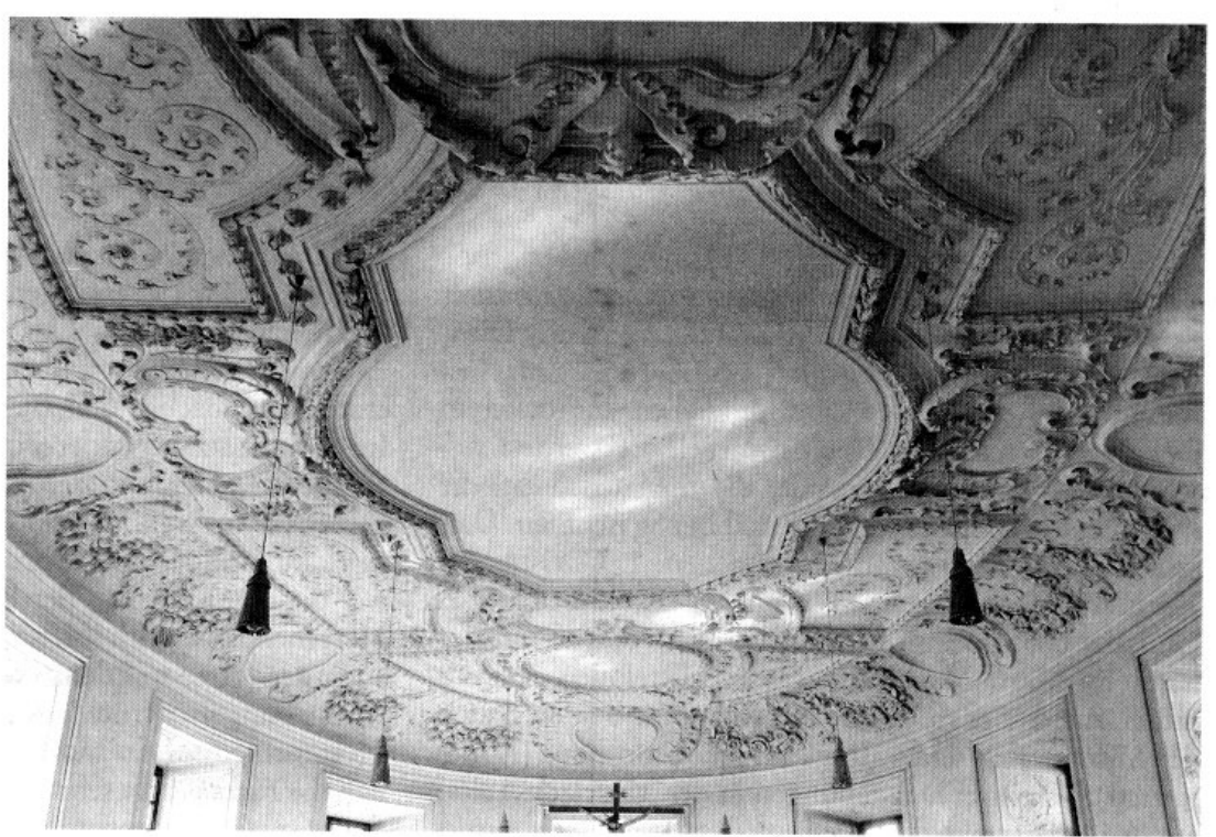
Abb. 3: Oberes Refektorium (heute Hauskapelle), Stuckdecke, Blick nach Süden. Foto: Carla Th. Mueller, München
