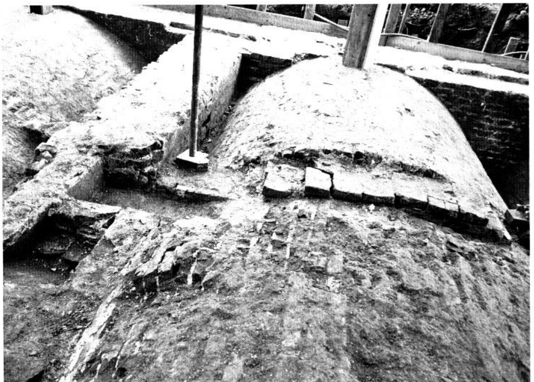
Abb. 9: Ehemaliges nordwestliches Sommerhaus im Dachauer Hofgarten. Aufsicht auf die freigelegten Gewölbe und Grundmauern.
