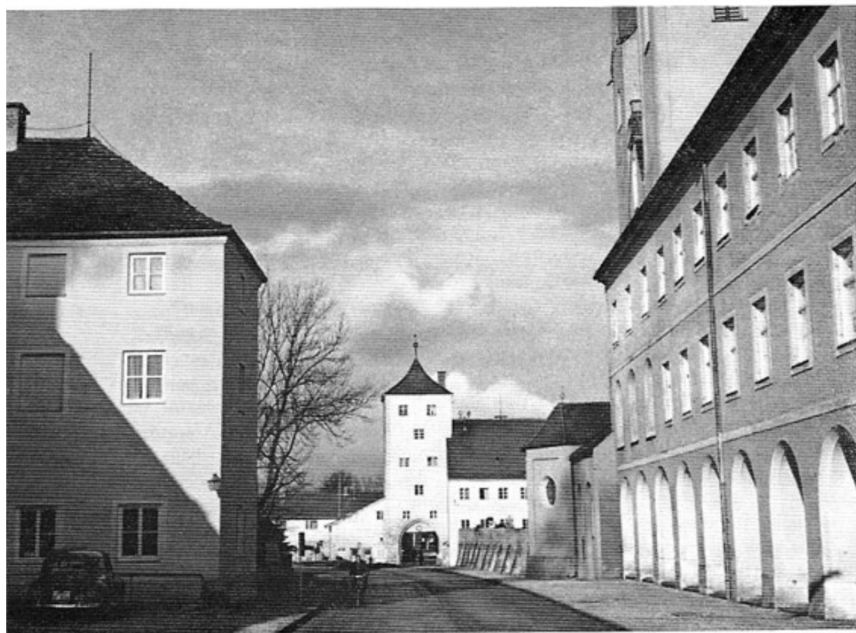
Neue Umgebungsstraße beim Indersdorfer Schneiderturm
