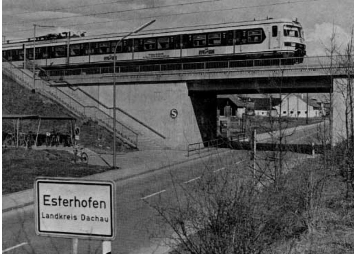
Unterführung Esterhofen mit S-Bahnstation.
