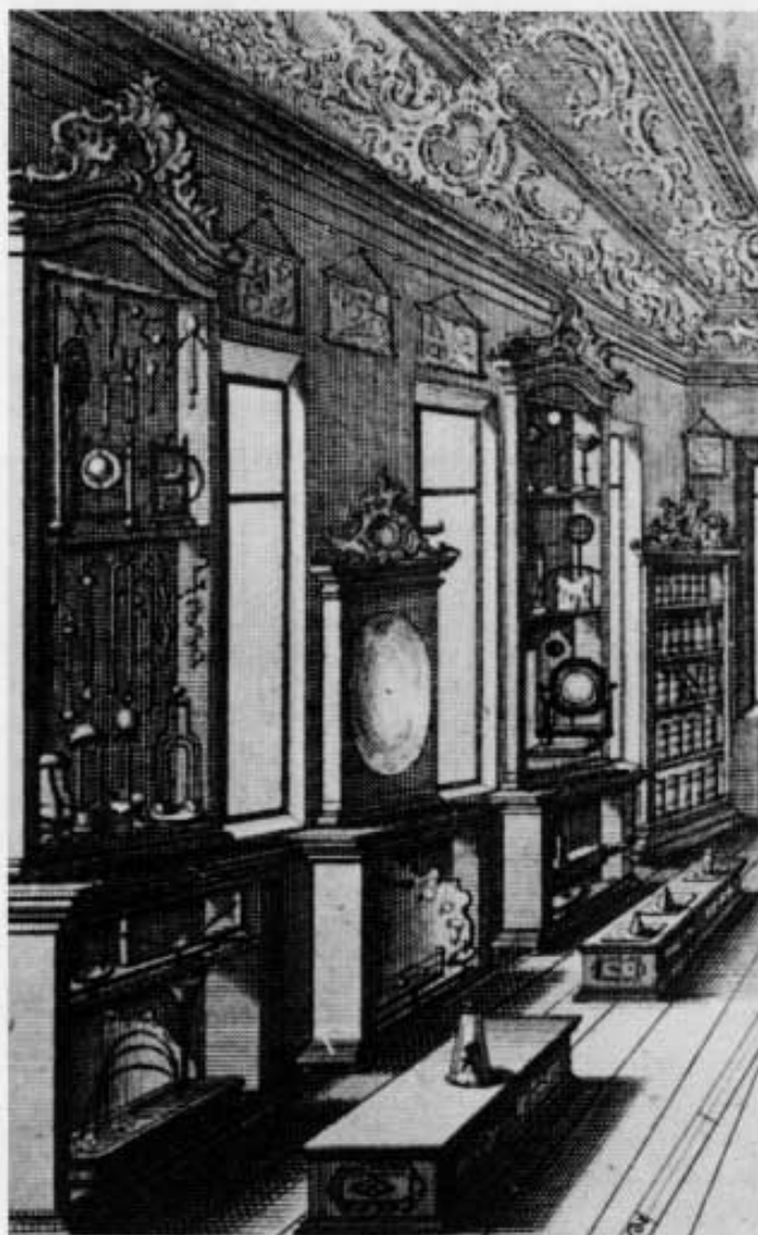
Abb. 6: Linke Seite des Indersdorfer Physiksaales mit hydro-mechanischen und optischen Geräten.
