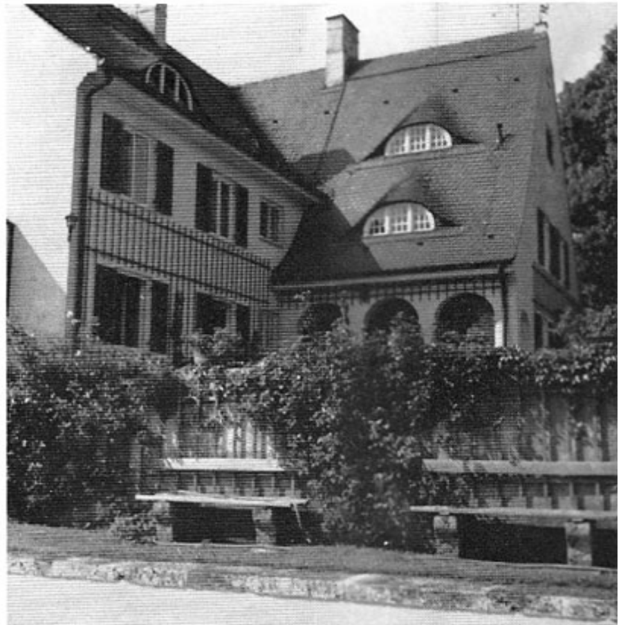
Abb. 2: Taschner-Haus, Ostfassaden und Südloggia.
