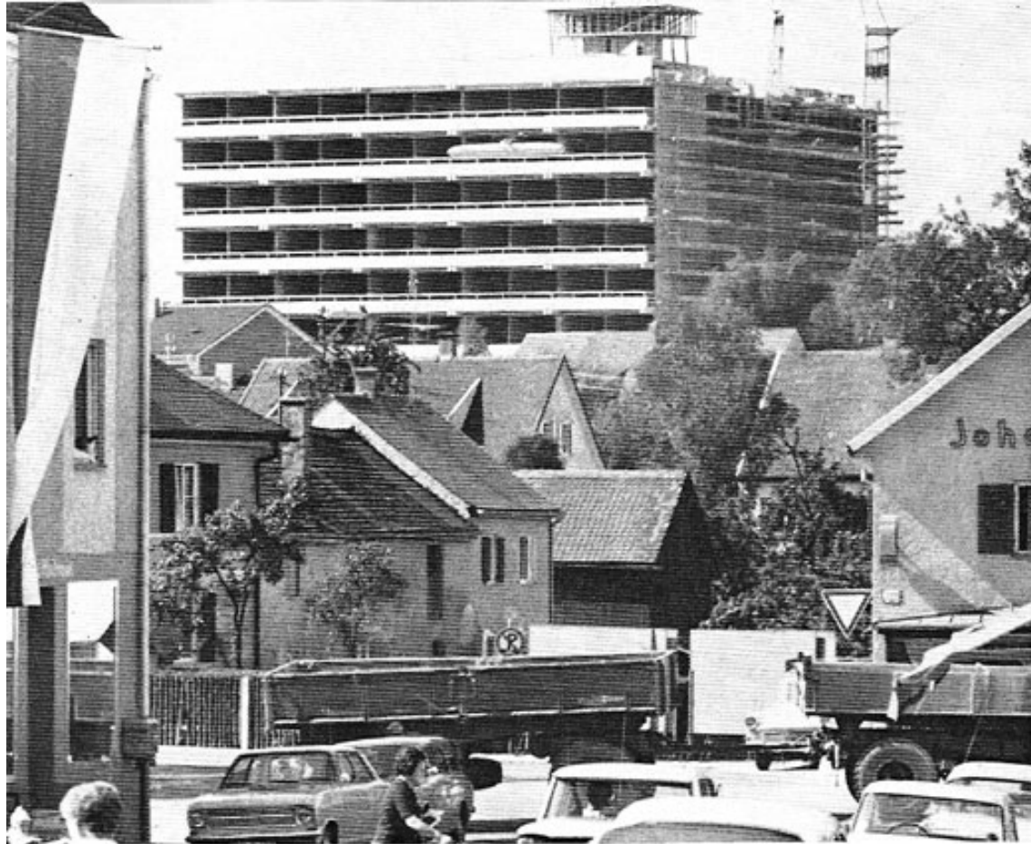
Das neue Kreis Krankenhaus in Dachau im Bau.
