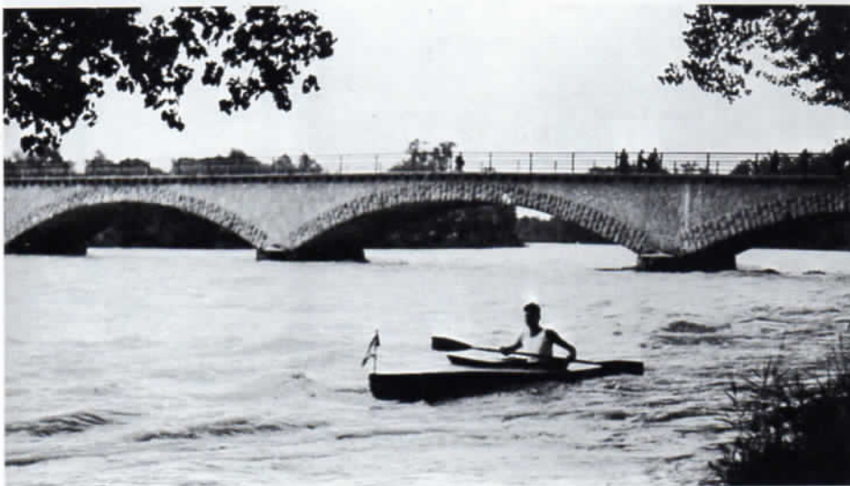
Die 1948 erbaute Freisinger Isarbrücke.
