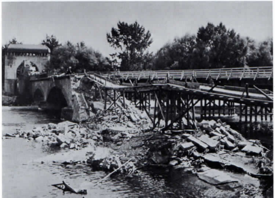
Die im Jahre 1945 zerstörte Freisinger Isarbrücke von 1894.
