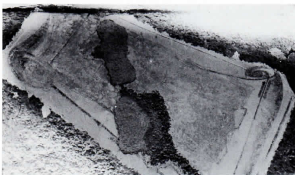
Abb. 3: Das am Schleißheimer Uhrenturm freigelegte Sonnenuhr-Zifferblatt.
