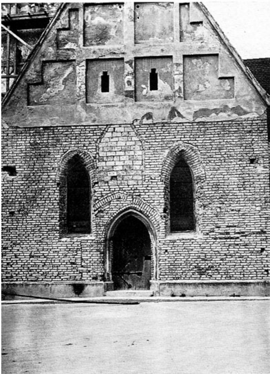
St. Leonhardskirche in Fürstenfeldbruck während der Renovation
